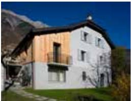
Une enveloppe extérieure performante (18 cm d'épaisseur), des fenêtres à triple vitrage, une chaudière à pellets, un système de ventilation, des panneaux solaires thermiques et d'autres photovoltaïques, et au bout du compte, l'architecte Léonard Bender a fait de la maison villageoise de ses grands-parents, à Châtagnier (Fully) la première rénovation suisse à atteindre le standard MINERGIE-A-ECO.
