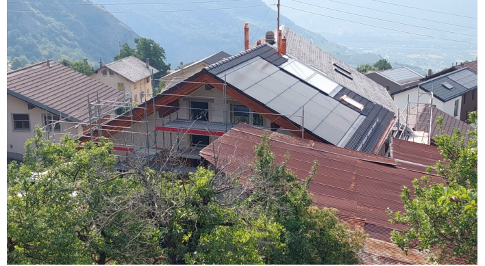
SOLAIRE THERMIQUE ET PHOTOVOLTAÏQUE
