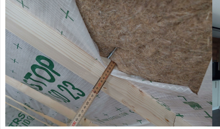
ISOLATION TOITURE INTERIEURE LAINE DE BOIS
