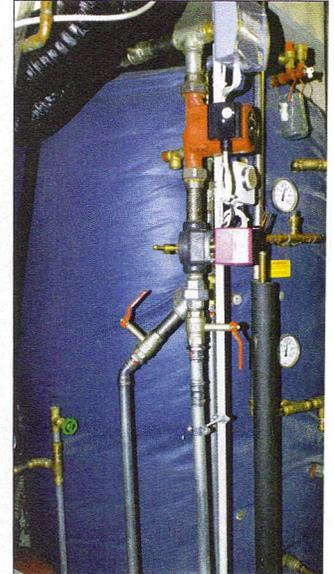
Local technique: un accumulateur d'eau chaude de 1280 litres est chauffé par l'installation solaire thermique. L'appoint est fourni par un poêle à bois de 8 kW de puissance.
