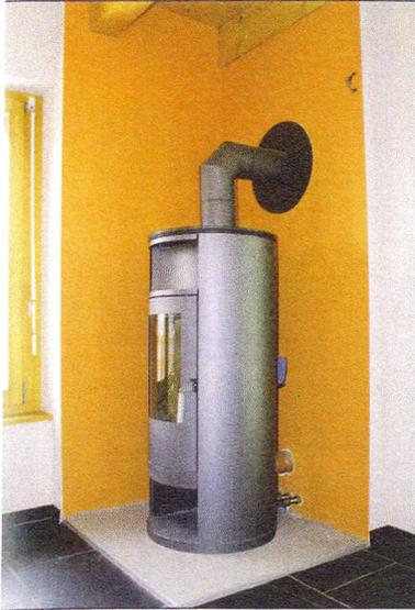
70% de la chaleur d'un poêle à bois de 8 kW le puissance servent à chauffer l'eau de l'accumulateur, 30% la pièce elle-même.
