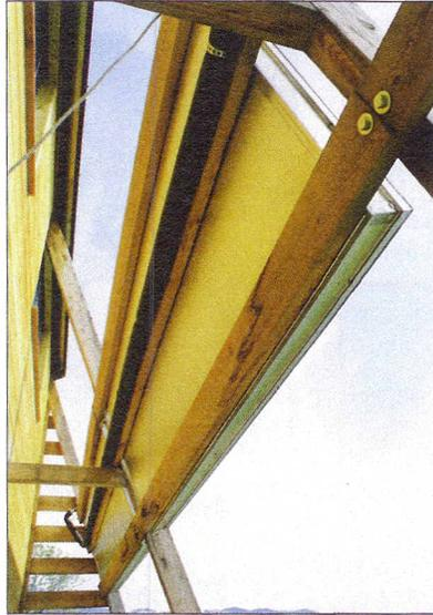
Balcon: en plus de jouer le rôle de grand brise-soleil, les capteurs assurent 100% de la préparation de l'eau chaude sanitaire et 56% de la production de chaleur nécessaire au chauffage.
