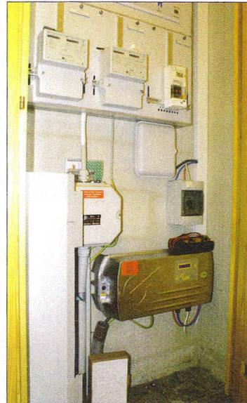
Le tableau électrique avec ses deux compteurs, le premier enregistrant la consommation, l'autre la production d'électricité des panneaux photovoltaïques injectée dans le réseau public. En bas, un onduleur transforme en courant alternatif le courant électrique continu produit par les panneaux solaires.
