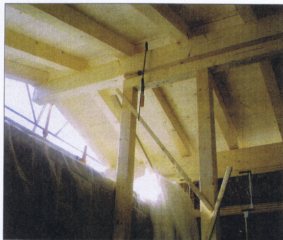
La charpente en bois européen est traitée à l'huile naturelle.
