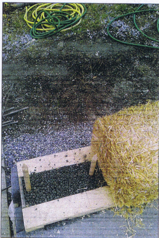
Base des murs en matériaux hydrophobes, lit de granulés d'argile et bottes de paille.
