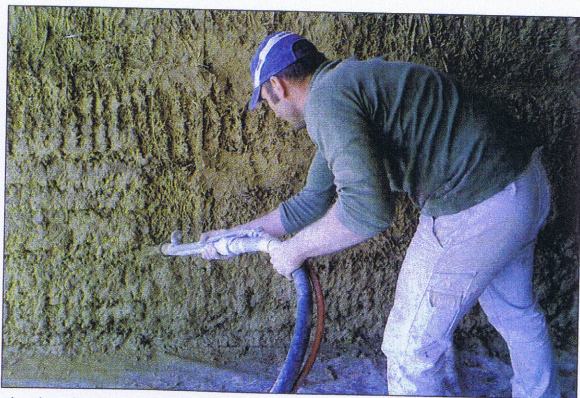
L'enduit de terre est appliqué à l'intérieur.
